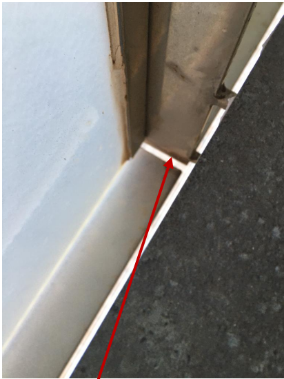
Soldadura suelta de la barandilla.
