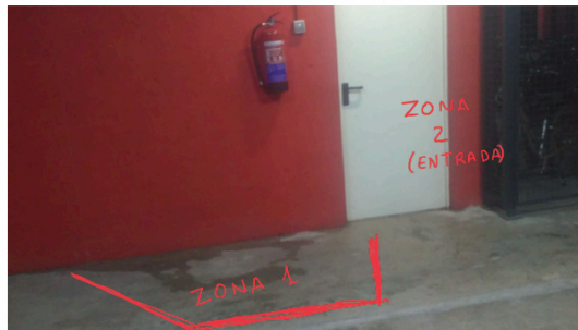
Zona 1: filtraciones por la pared.
