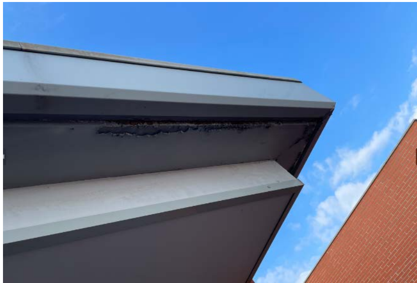
Fotografía nº 32: Defectos de corrosión de los remates de chapa.
