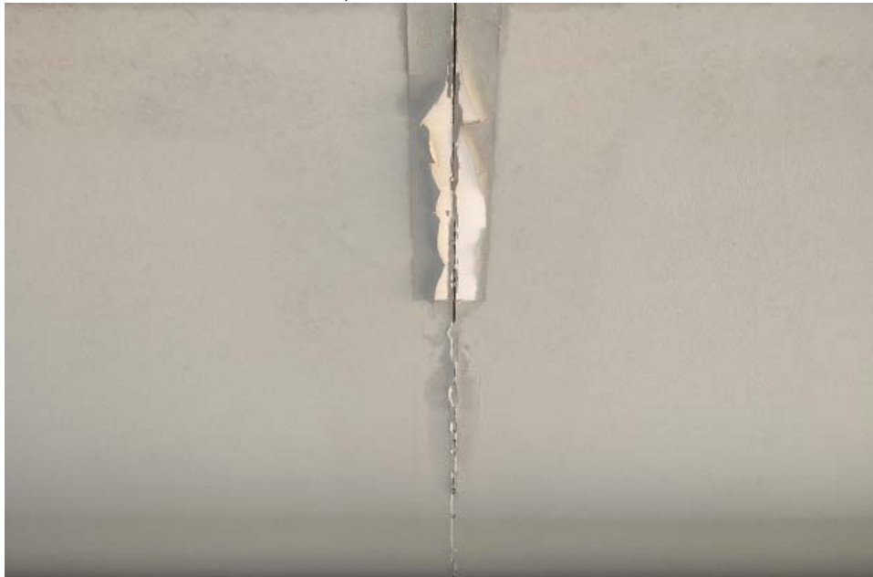
Fotografía nº 27: Filtración de agua en falso techo cornisa. Material de acabado no adecuado para la intemperie.
