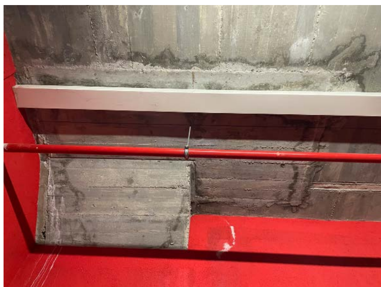
Fotografía nº 13: Vista inferior de la escalera de acceso al garaje, con manchas de humedad.
