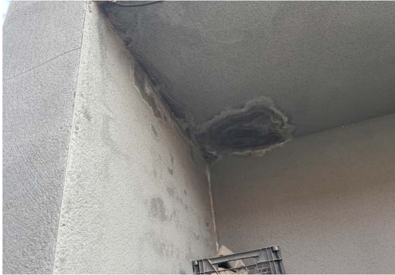
Fotografía nº 30: Filtración de agua por el techo del módulo de la escalera B.
