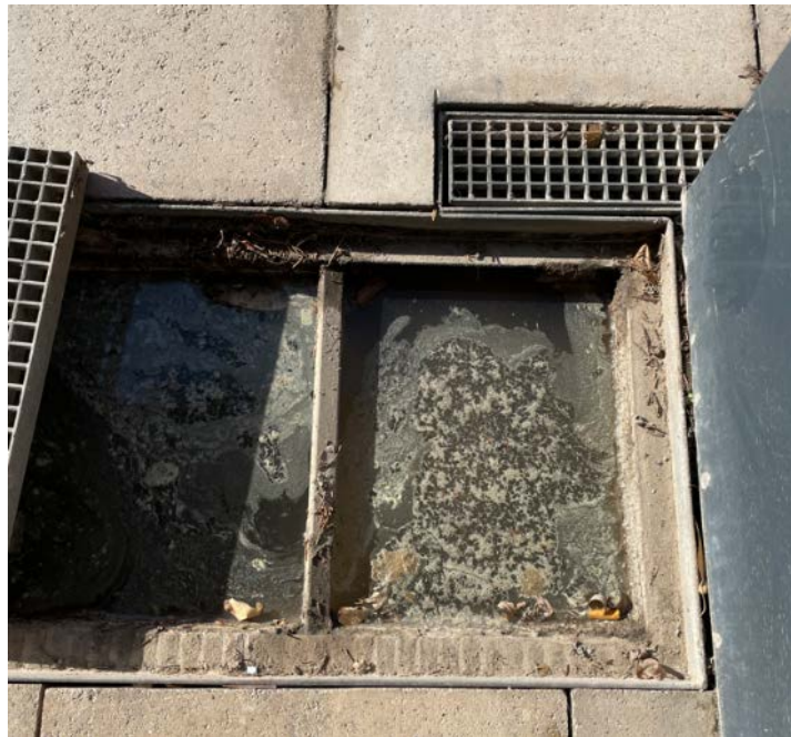
Imagen. 10. La reja se encontraba completamente atascada.
