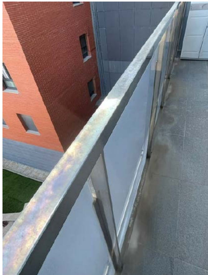
Fotografía nº 23: Desperfectos por filtración de agua pluvial mezclado con cal (3ª Escalera B).
