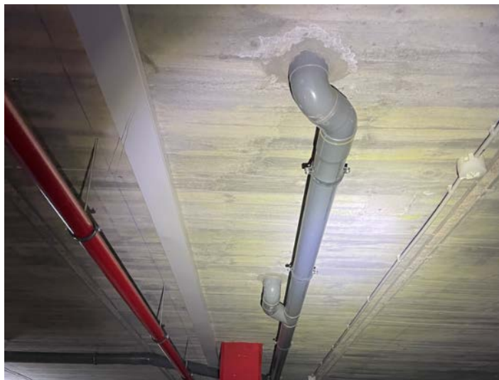
Imagen.11 Desagüe de la canal de drenaje de la plaza interior.
