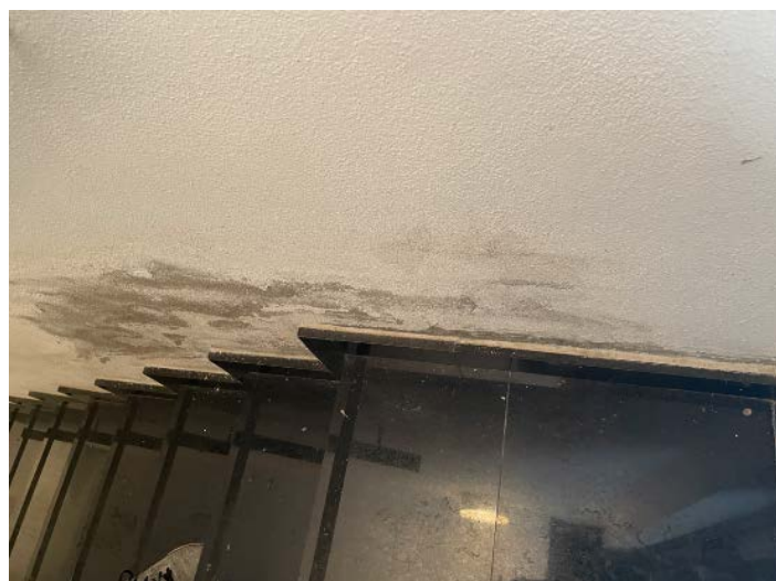
Imagen.12 Filtración de agua en la escalera B, acceso al garaje.
