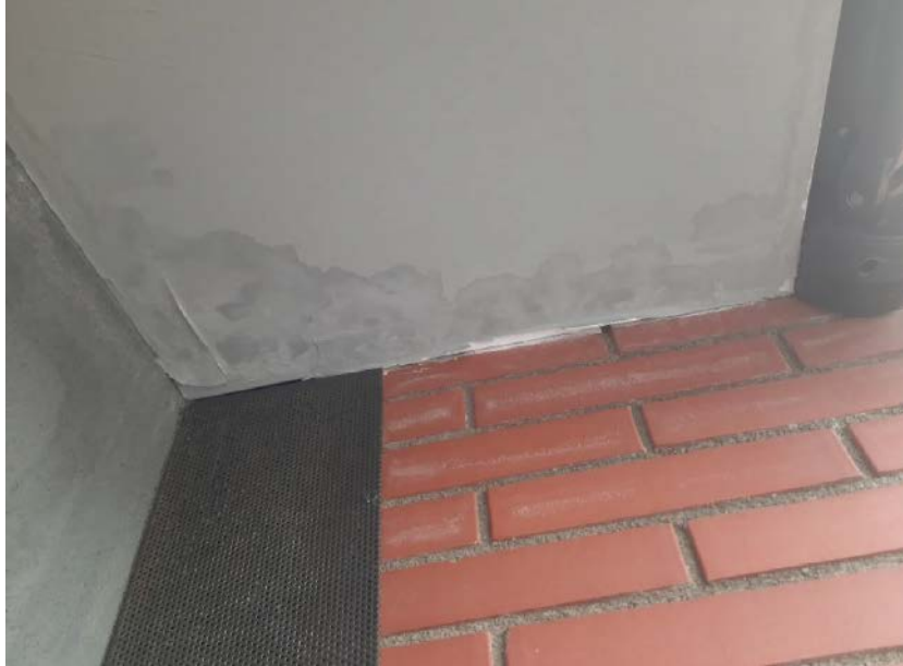
Fotografía nº 24: Filtración de agua por el voladizo de la cubierta, provocado por un fallo de impermeabilización del paso de instalaciones en la cara superior. Material de cornisa inadecuado para su uso en el exterior.
