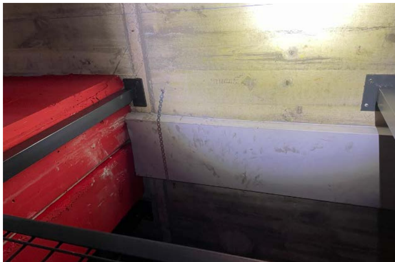
Fotografía nº 16: Impermeabilización inferior de la junta de dilatación estructural del edificio en la escalera B, con signos de filtración de agua.
