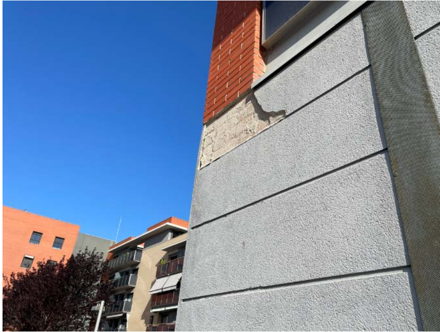
Fotografía nº 38: Desprendimiento de mortero en la esquina posterior la escalera D.
