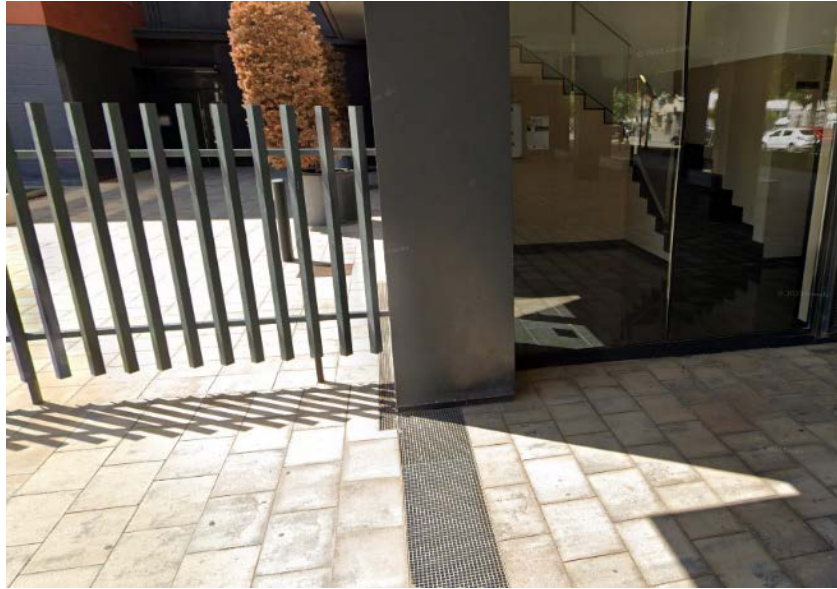
Imagen. 9. Reja de drenaje comunicada con la reja de la escalera B, y con la red de desagüe en el techo del garaje. La junta de dilatación estructural transcurre en paralelo a la cristalera.
