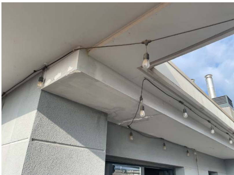
Fotografía nº 28: Filtración de agua en falso techo cornisa. Material de acabado no adecuado para la intemperie.
