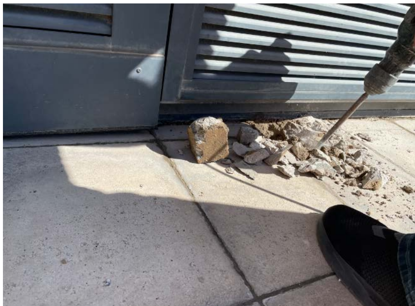
Fotografía nº 18: Realización de la cata en el acceso hacia el garaje en escalera B.
