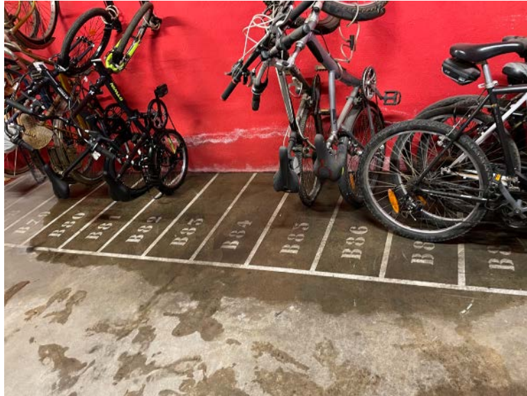
Fotografía nº 14: Acumulación de agua pluvial en los estacionamientos de bicicletas en la escalera B.
