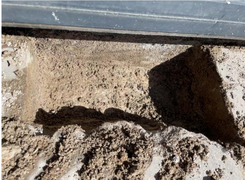
Fotografía nº 19: En la cata realizada no se encuentra una impermeabilización en el encuentro entre fachada y forjado. En el fondo de la cata se aprecia la presencia de agua. En la pared de hormigón del fondo se aprecia la aplicación de una imprimación asfáltica, o similar.
