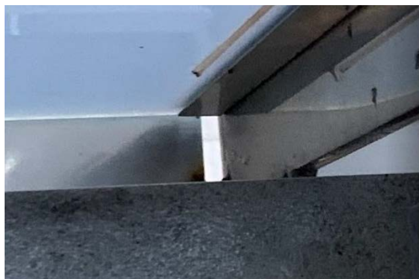
Fotografía nº 35: Perfil de remate inferior despegado en vivienda 2ª1ª, esc. C.
