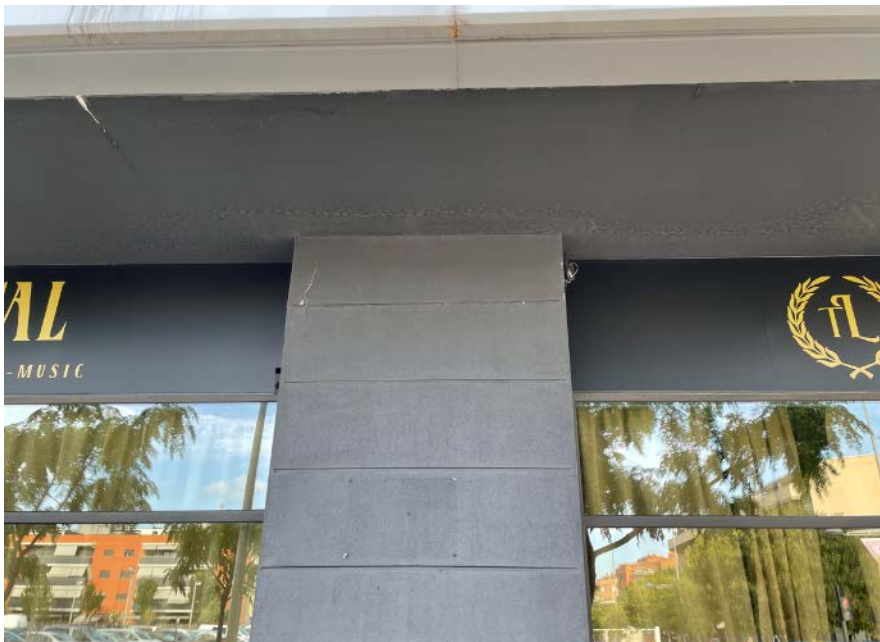
Fotografía nº 39: Acabado exterior inadecuado en el canto inferior de los balcones, realizados con placas PYL para interiores, o sin una protección para su uso en el exterior.
